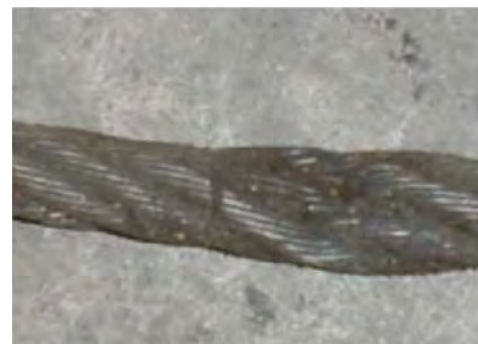
DETERIORO POR USO
